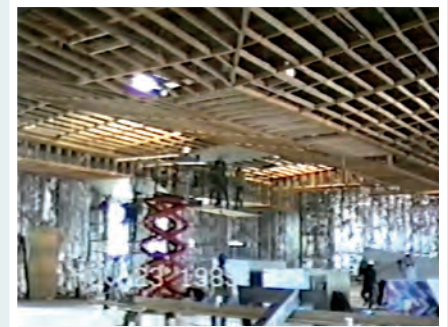
• Khung trần nhà đã hoàn tất.
