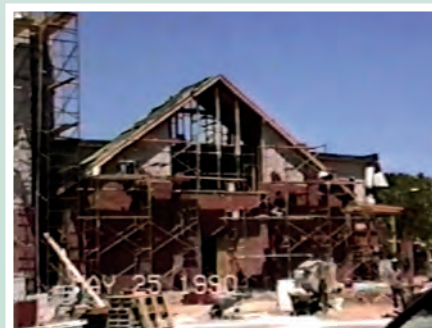
• Gạch lót ngoài đang được xây lên.
