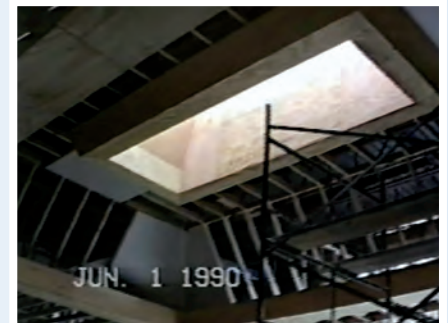
• Gian cuối thánh đường đang xây cất.
