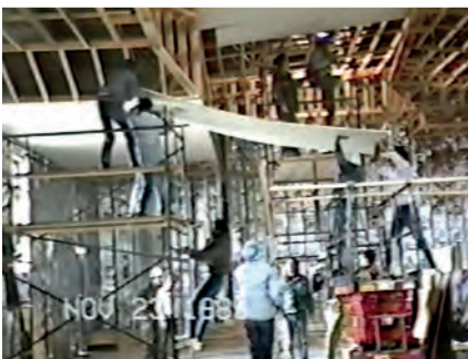
• Các anh em giáo dân đang lợp trần nhà trong thánh đường.
