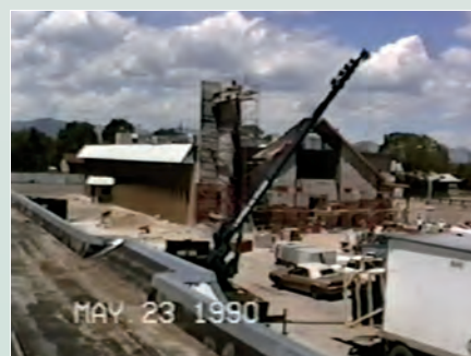
• Thánh đường đang xây nhìn từ phía nóc nhà hội trường thánh Giuse.
