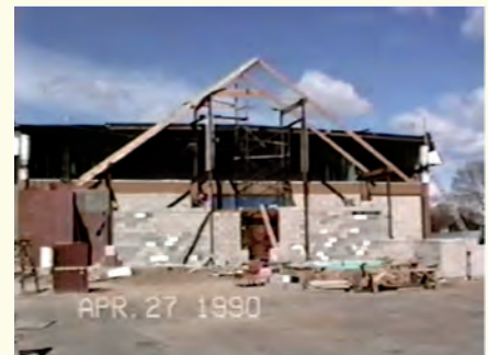
• Mặt tiền của thánh đường đang được dựng lên.
