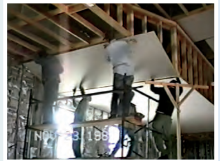
• Trần nhà thánh đường đang được ráp nối.
